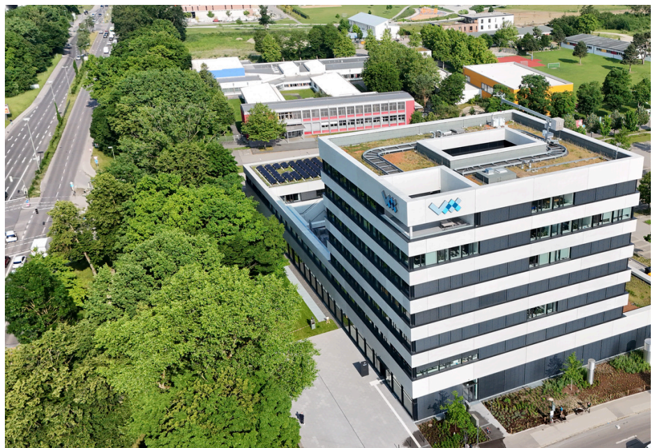
Fotos: Wohnbaugruppe Augsburg (3)
